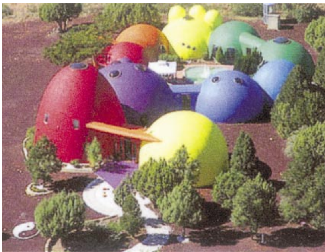
Monolithische Kuppelbauten lassen sich selbst herstellen und sind längst keine Zukunftsvision mehr.
